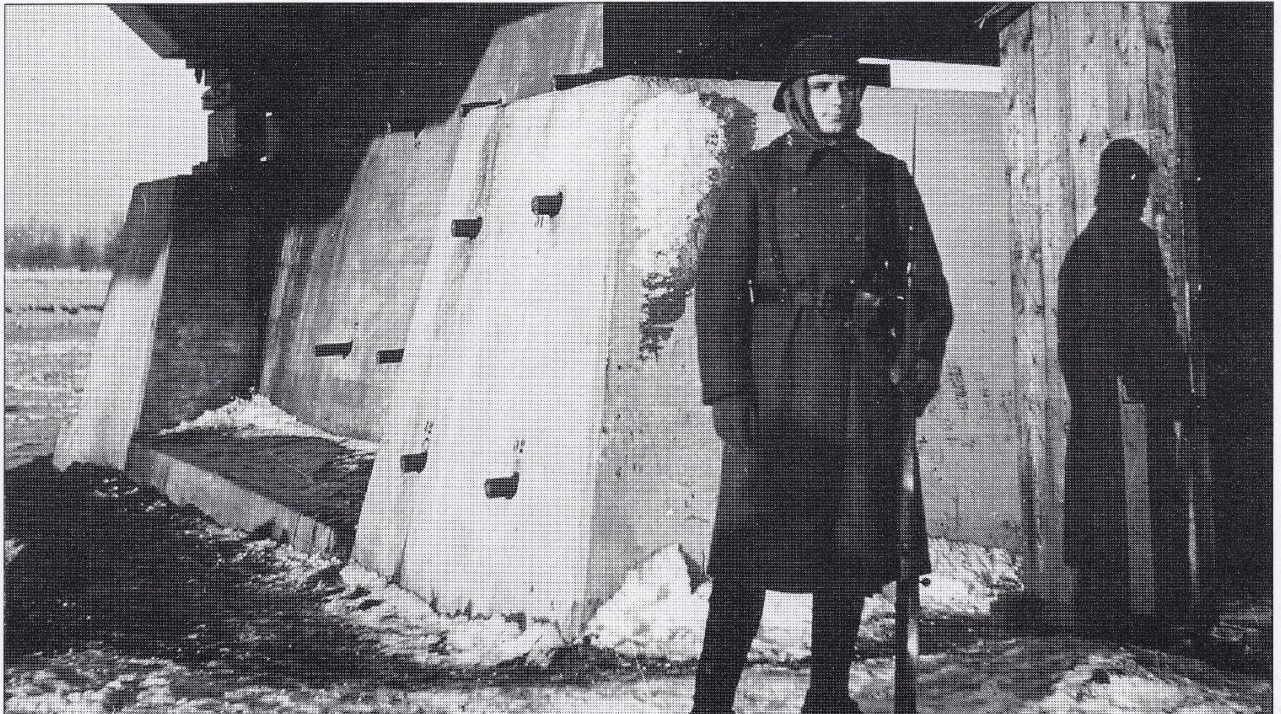
Op wacht onder de brug over het Twente-Rijn-kanaal in de weg Bornerbroek-Enter, 1940. De springladingen zijn duidelijk te zien.
