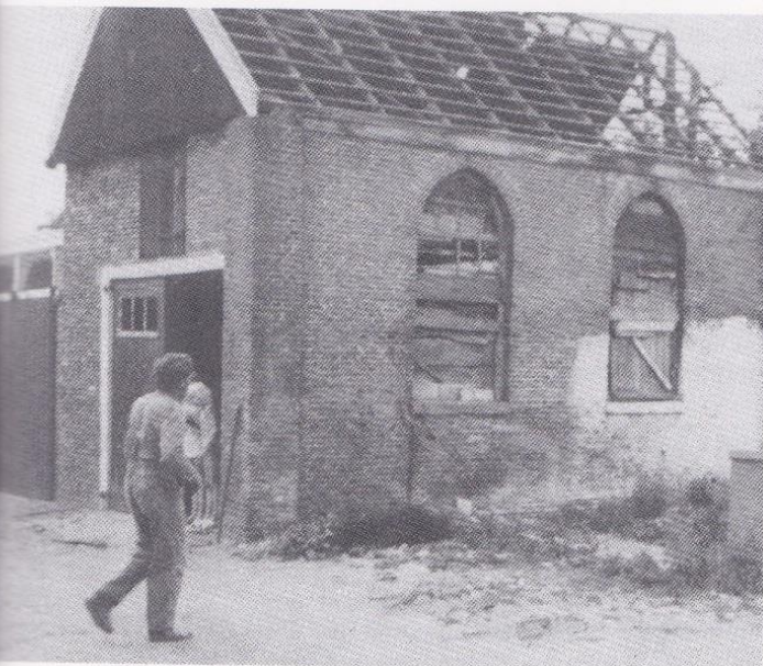
De aloude school van Enter wordt hier afgebroken.
